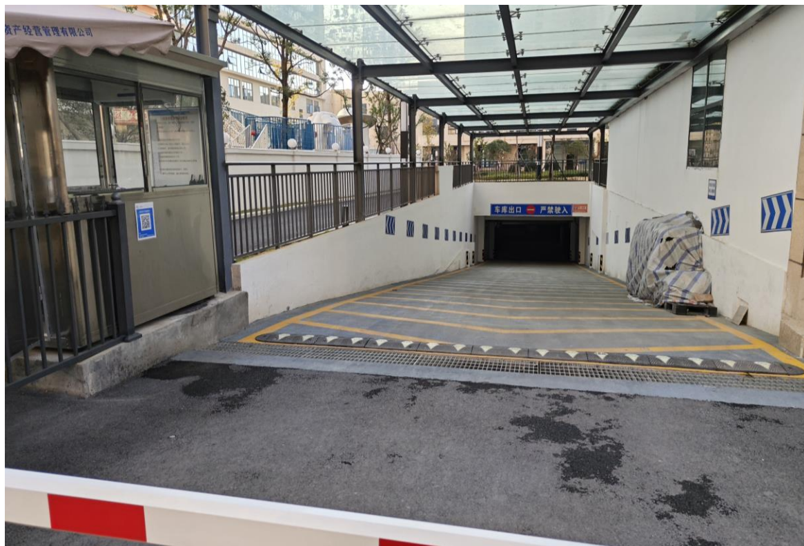
地下室出口排水沟（2024.11）
